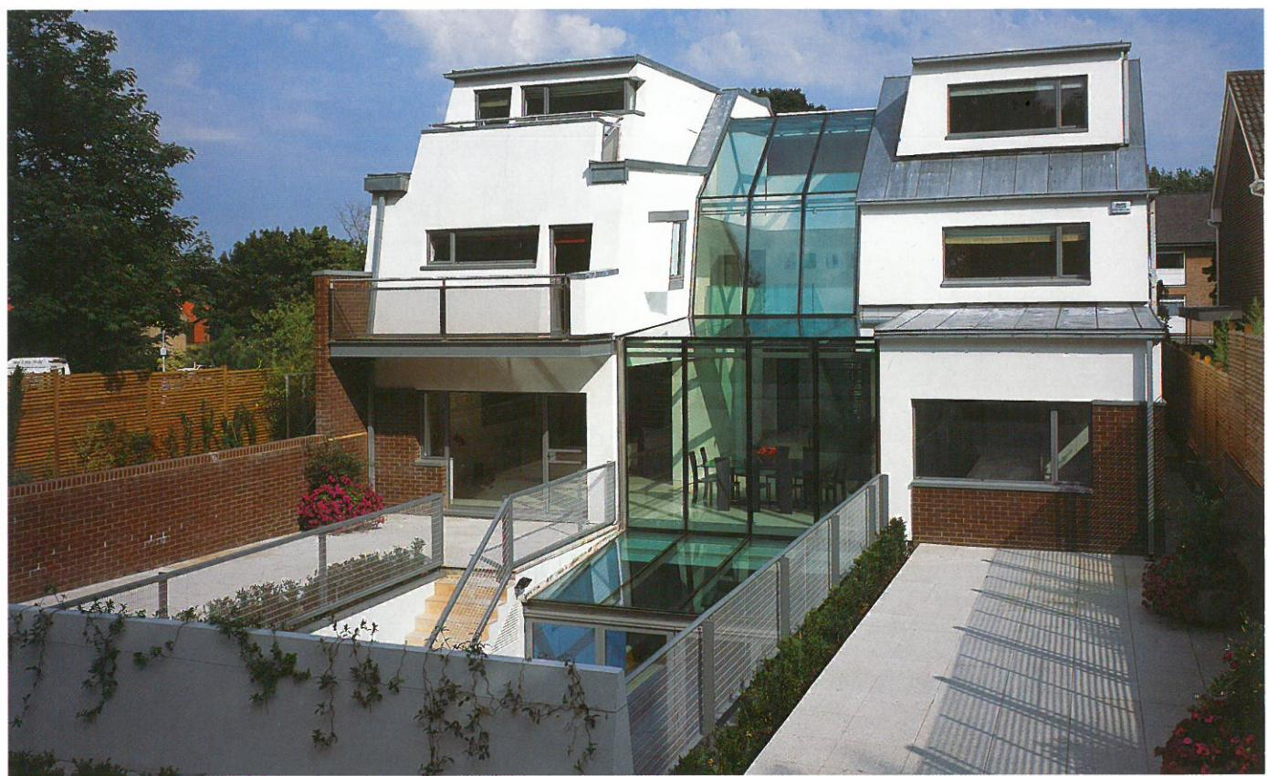
Архитектор предложил использовать при строительстве двухслойное ламинированное стекло, которое является безопасным материалом: при разрушении оно не разлетается на куски
